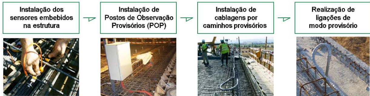
Figura 10 – Sequência dos trabalhos de instalação durante a fase de construção.
