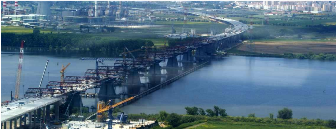
Figura 2 – Fase da construção da ponte da Lezíria, em Maio de 2007.
