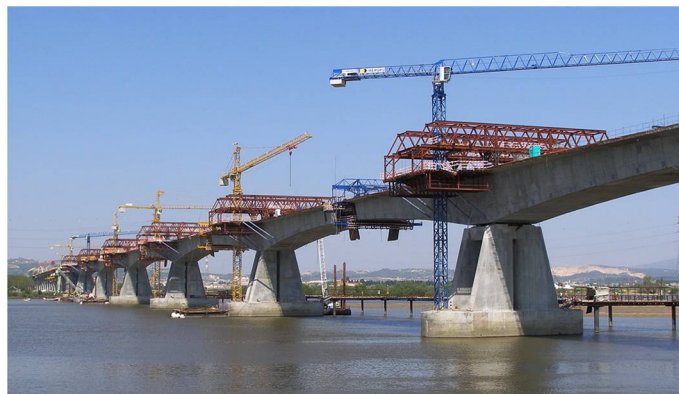
Figura 1 – Ponte da Lezíria (fase de construção em Maio 2007).
